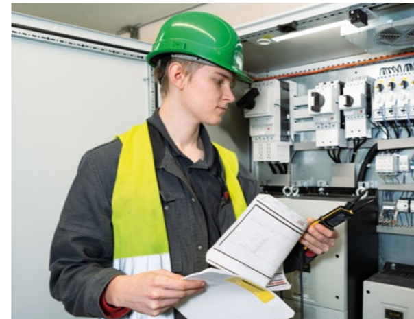
Der ehemalige Auszubildende Ole Voss sucht im Auftrag von DIM eine Störung an einem Förderband der Euroports-Germany-Gruppe im Industriehafen in Rostock.
